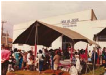
Núcleo José Esteves - no término da sua construção
